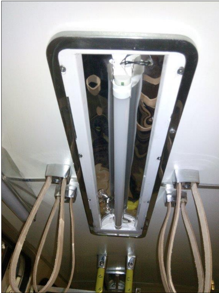
13.8: Az átszerelésről készített fotó
