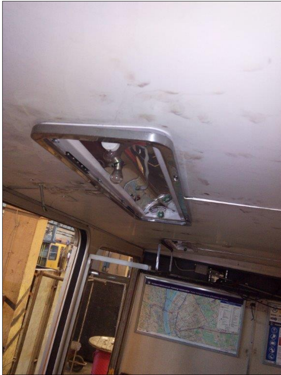
13.7: Az átszerelésről készített fotó
