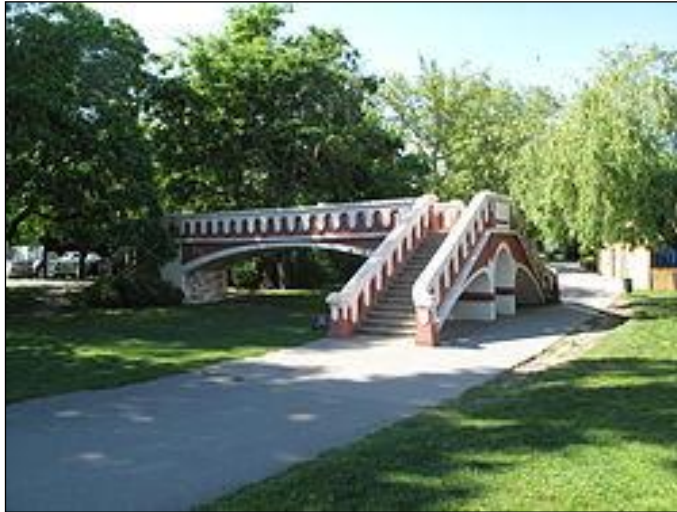
2.3. ábra: Magyarország első vasbetonhídja, most [3]
