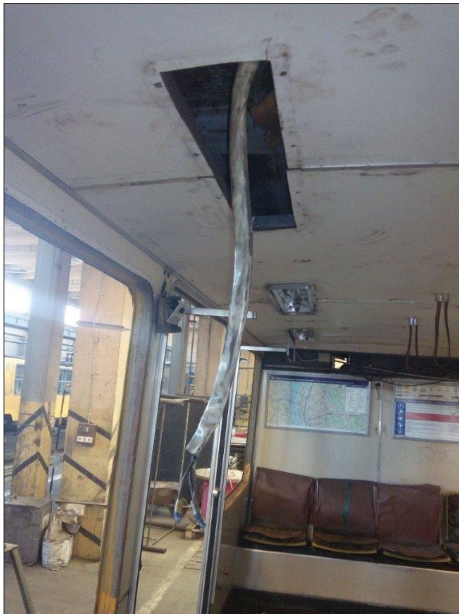
13.6: Az átszerelésről készített fotó
